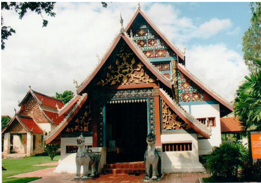
ภาพที่ 11 วิหารวัดหนองบัวมีลักษณะทรงเตี้ยแจ้ มีโครงสร้างหลังคา ลดระดับความยาวลงมาต่ำ ตั้งอยู่บนฐานบัวคว่ำ ด้านหน้าย่อมุมเป็นมุขโถง มีสิงห์คู่ประดับอยู่หน้าวิหาร
