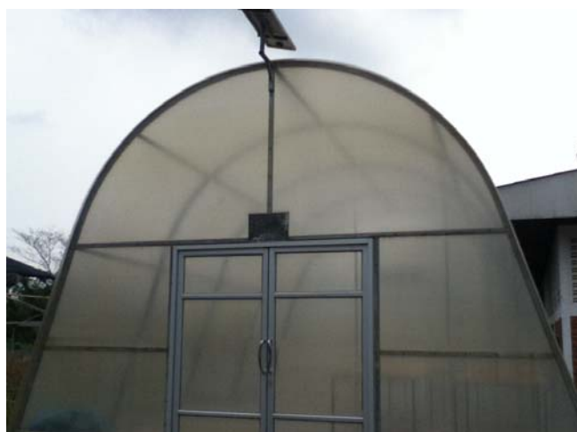
รูปที่ ผ.2.3: ตู้อบพลังแสงอาทิตย์แบบเรือนกระจก
