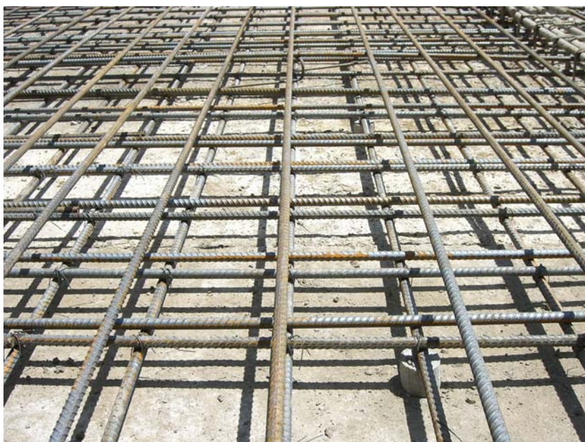
ภาพที่ 62 รากสายดินฐานรากที่ใช้เหล็กเสริมพื้นชั้นล่างสุดของสิ่งปลูกสร้างเป็นรากสายดิน
