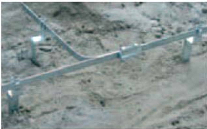
ภาพที่ 32 การยึดตัวนำด้วย Special Spacers ก่อนการเทคอนกรีต
