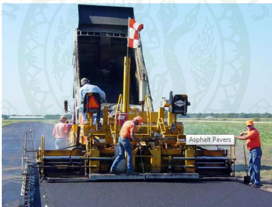
ภาพที่ 20 เครื่องปูขณะดำเนินการก่อสร้าง
