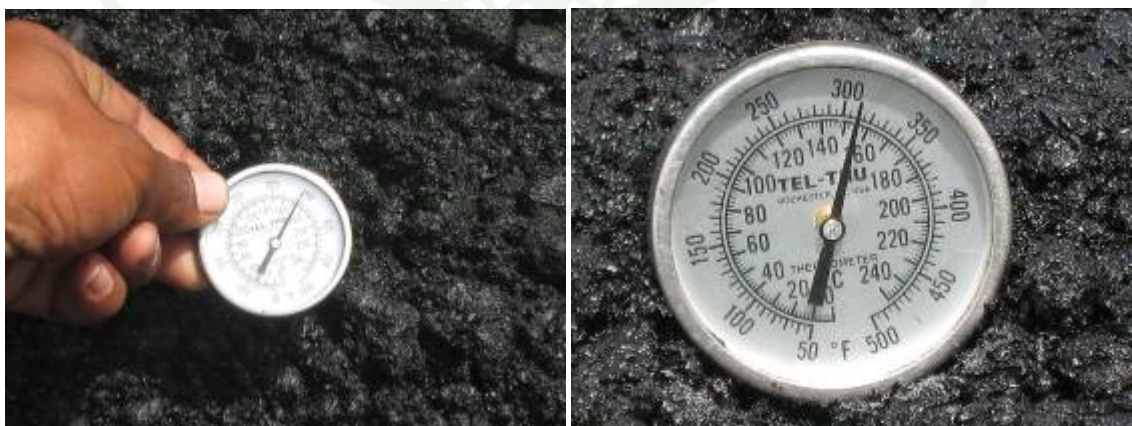
ภาพที่ 68 การวัดอุณหภูมิที่ท้ายรถบรรทุก ณ พื้นที่ก่อสร้าง
