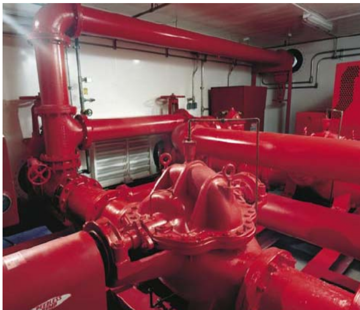
ภาพที่ 11 การติดตั้งเครื่องสูบน้ำดับเพลิงแบบนอน
