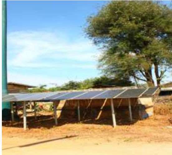
ภาพที่ ข.10 แผงโซลาร์เซลล์ที่นำมาใช้ในการสูบน้ำของกลุ่มประปาหมู่บ้านภูไทพัฒนา
