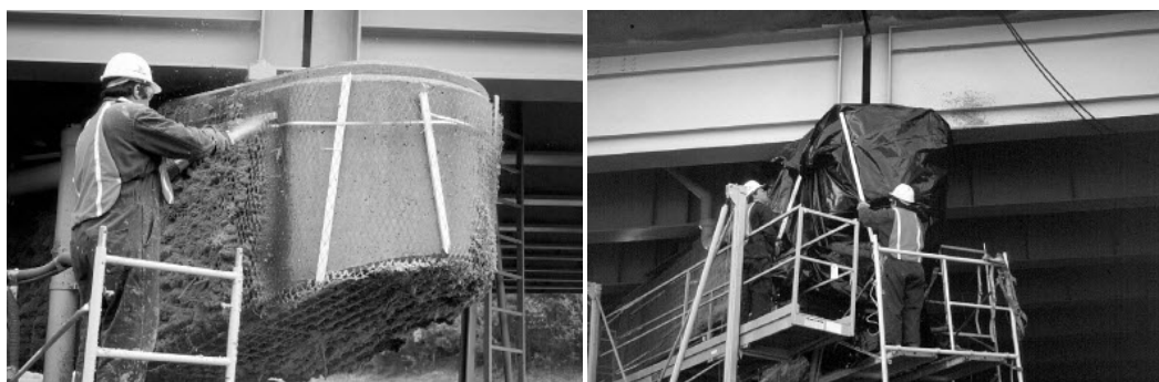
ภาพที่ ก5 แสดงการติดตั้งอุปกรณ์ในการติดตั้งอุปกรณ์ในการลดปริมาณคลอไรด์ใน โครงสร้าง ต่อม่อสะพาน I-365
