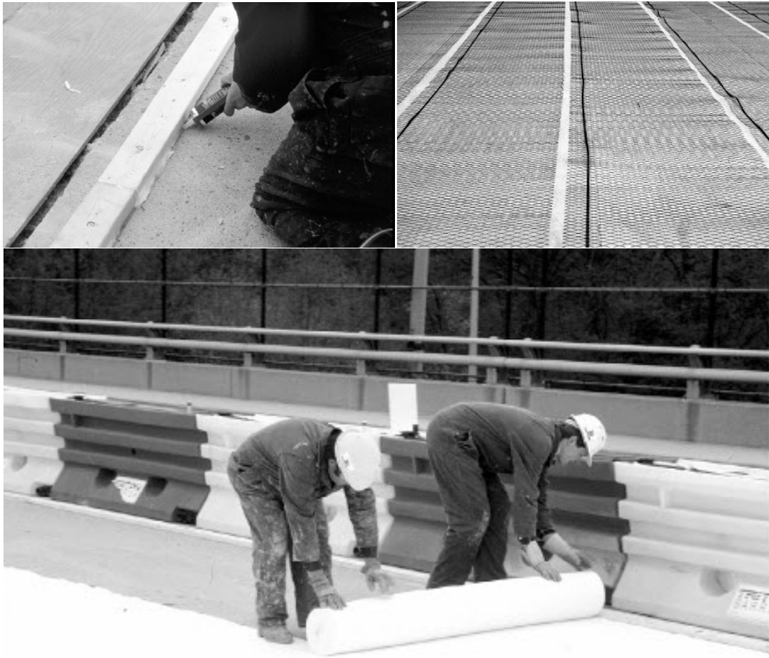
ภาพที่ ก3 แสดงการติดตั้งอุปกรณ์ในการติดตั้งอุปกรณ์ในการลดปริมาณคลอไรด์ใน โครงสร้าง พื้นสะพาน I-365
