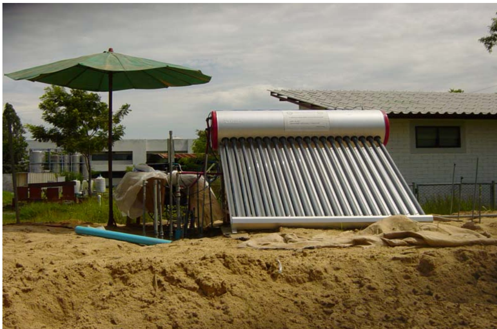
ภาพที่ 72 การวางเครื่องผลิตน้ำร้อนจากพลังงานแสงอาทิตย์หลังจากถมทราย
