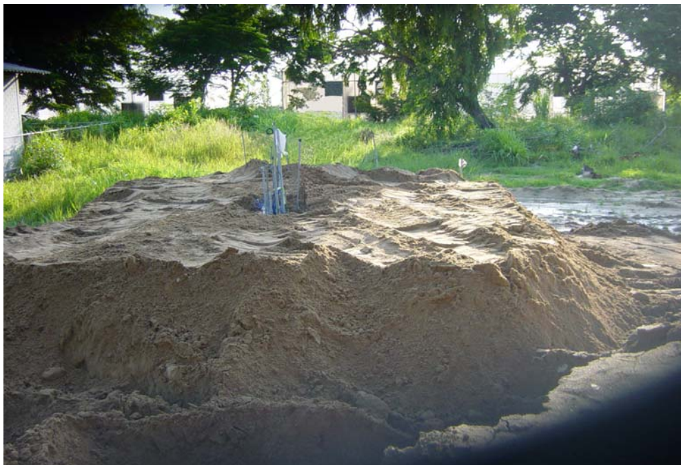
ภาพที่ 70 การถมทรายเพื่อปรับสภาพพื้นดินให้อยู่ในสภาพ OCR = 1
