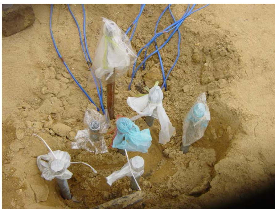
ภาพที่ 64 ลักษณะการติดตั้งอุปกรณ์วัดการทรุดตัวระดับลึกของชั้นดิน (Deep Settlement Plate)
