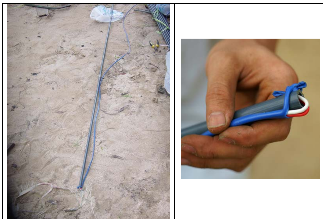
ภาพที่ 45 สายไฟวัดอุณหภูมิ (Thermocouple) และท่อนำการติดตั้ง
