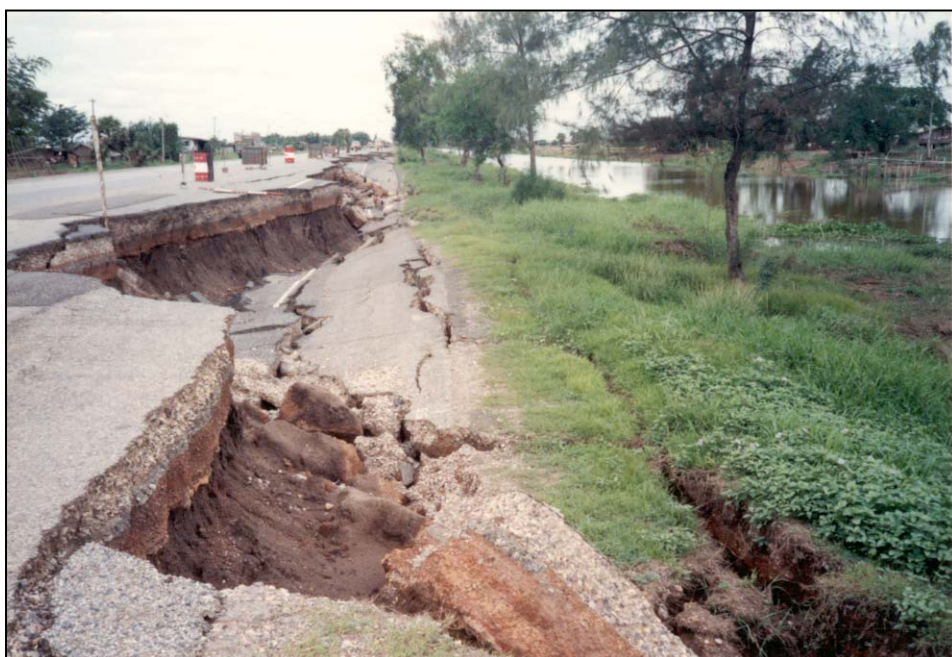
ภาพที่ 3 ปัญหาที่เกิดจากเสถียรภาพต่ำของฐานรากดินเหนียวอ่อน ที่มา: Bergado et al. (1992)
