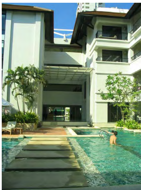
ภาพที่ 60 บริเวณทางเดินเชื่อมต่อระหว่างตึกผ่านสระว่ายน้ำ
