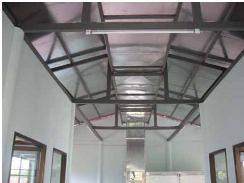
รูปที่ 3.5 ท่ออากาศที่แนวบรรจบของแผงรับรังสีดวงอาทิตย์ทั้งสองด้าน
