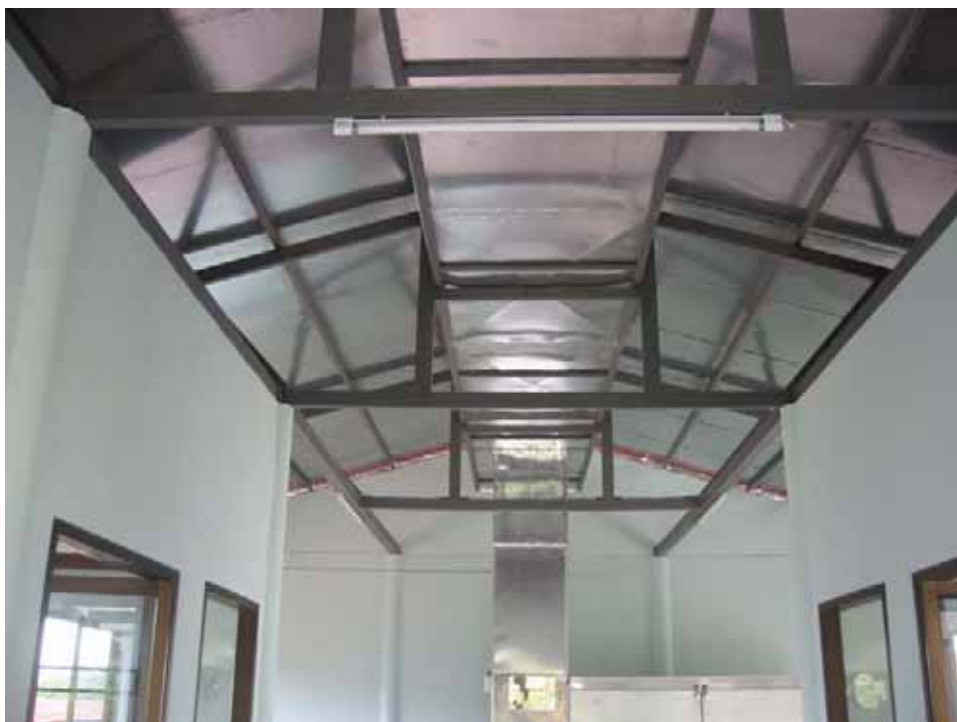
รูปที่ 3.13 แสดงภาพถ่ายของท่อนำอากาศจากแผงรับรังสีดวงอาทิตย์มายังตู้อบแห้ง
