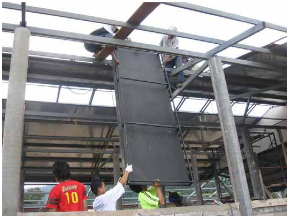
รูปที่ A1.7 แสดงการนำแผงรับรังสีดวงอาทิตย์ขึ้นไปติดตั้งบนโครงหลังคา
