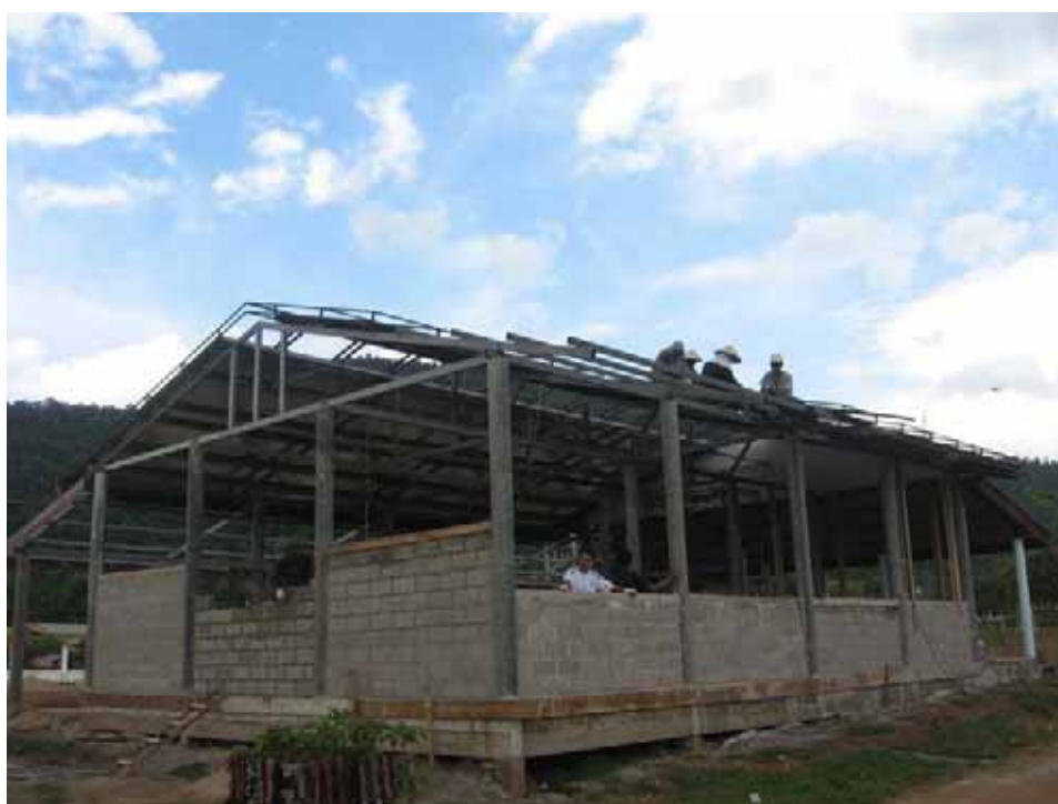
รูปที่ A1.6 แสดงการสร้างอาคารอบแห้ง
