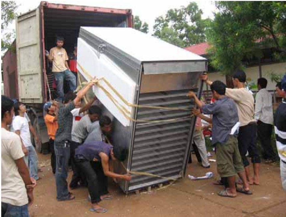
รูปที่ 2.55 แสดงภาพถ่ายการขนอุปกรณ์ลง ที่สถานที่ก่อสร้างต้นแบบที่วิทยาลัยเกษตรกรรมและป่า ไม้จำปาสัก
