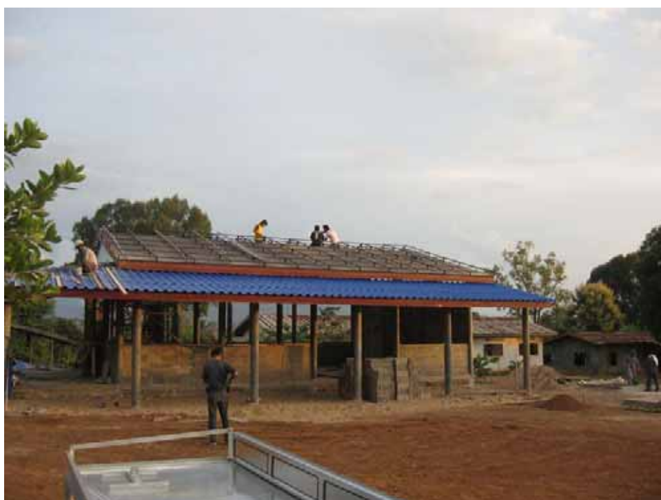
รูปที่ A1.8 แสดงการติดตั้งแผงรับรังสีดวงอาทิตย์
