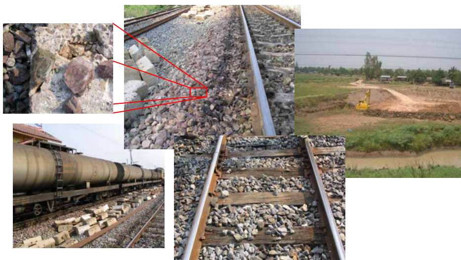
ภาพที่ 23 สาเหตุการเสื่อมโทรมของคันทางรถไฟในเส้นทางภาคเหนือตอนล่าง
