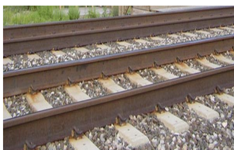
ภาพที่ 22 รางรถไฟที่ใช้ปัจจุบันเป็นราง 100 ปอนด์
