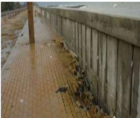
กำแพงซีท (Sheet pile)
