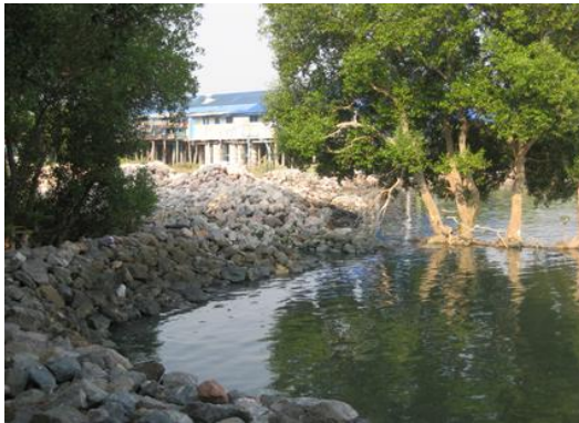
แนวหินทิ้ง ต. บ้านบ่อ
