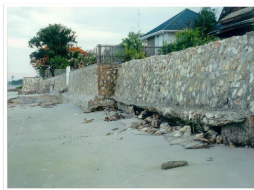
แนวกำแพงกันคลื่น (seawall) ที่ อ. ชะอำ
