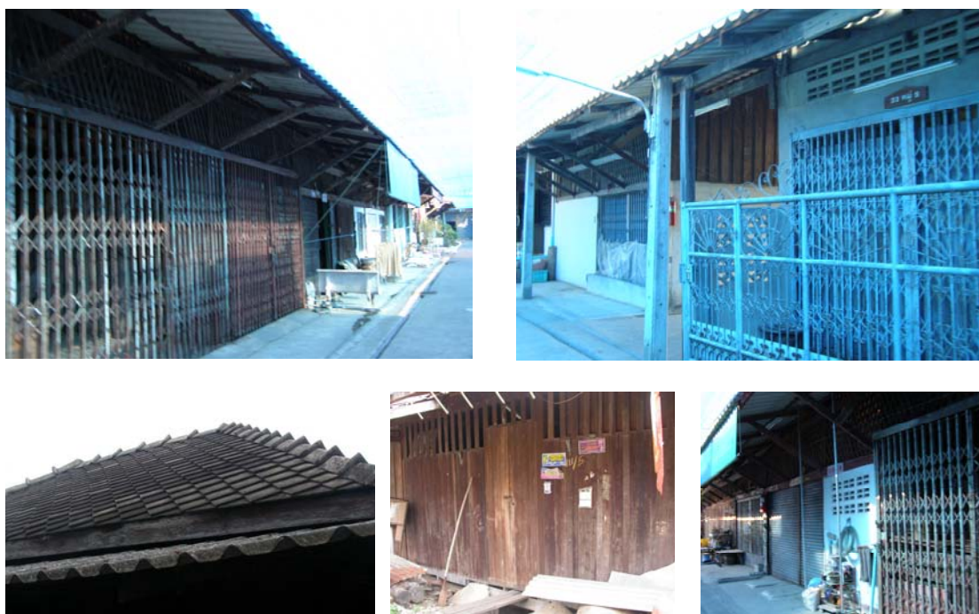
ภาพที่ 5.17 ห้องแถวไม้ ชุมชนริมน้ำตลาดใหม่
