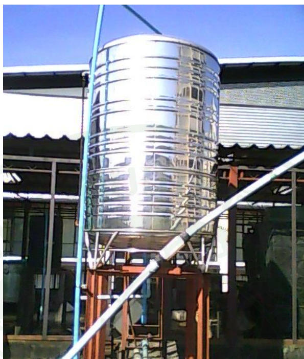
ภาพที่ 9 ถังเก็บน้ำขนาด 3000 ลิตร
