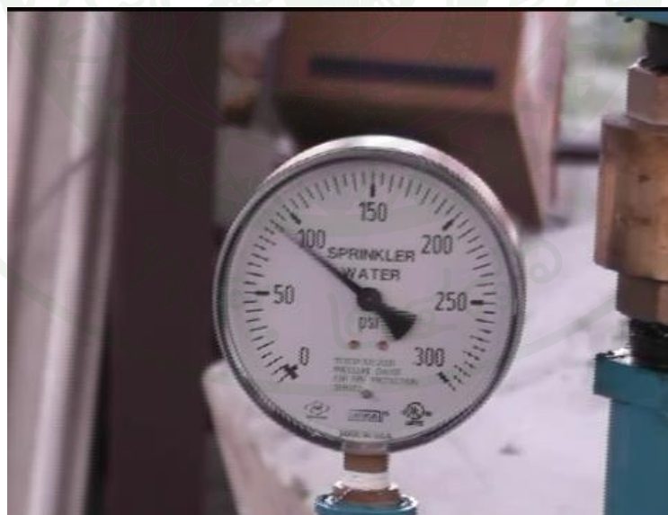
ภาพที่ 25 ค่า Maximum Chun Pressure 95 psi ที่ปั้มน้ำทำงานที่ความถี่ 90 Hz
