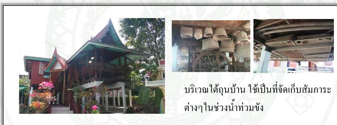
ภาพที่ 24 แสดงลักษณะบ้านไม้ใต้ถุนสูง (บ้านนายมานพ แก้วหยก) เพื่อเก็บสัมภาระไว้บริเวณใต้ถุนบ้าน ทั้งช่วงปกติและช่วงน้ำหลาก
