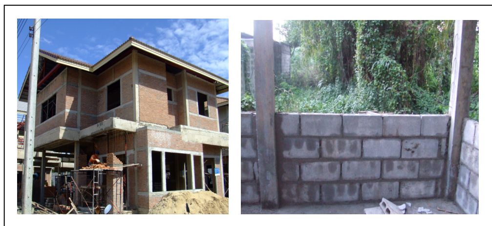
ภาพที่ 5 ผนังก่ออิฐฉาบปูน และผนังก่อคอนกรีตบล็อก
