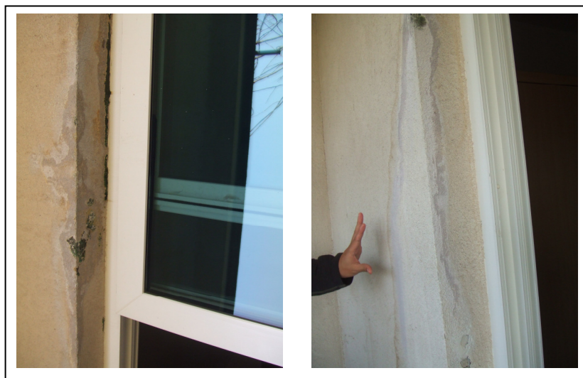
ภาพที่ 11 ปัญหาความชื้น จากฝนที่สาดโดนผนัง
