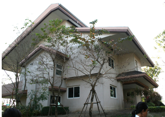
ภาพที่ 3 บ้านแบบ Active วัสดุผนัง EIFS ที่ตั้ง อ.คลองหลวง จ. ปทุมธานี ที่มา : บ้านประหยัดพลังงาน ประเภทบ้านเดี่ยว สำหรับกรุงเทพมหานครหรือจังหวัดใกล้เคียง ของกรมพัฒนาพลังงานทดแทนและอนุรักษ์พลังงาน โดย ศ.ดร.สุนทร บุญญาธิการ
