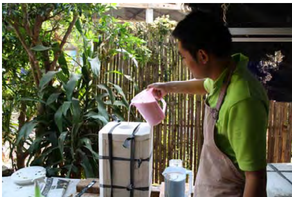
ภาพที่ 86 แสดงการหล่อชิ้นงาน
