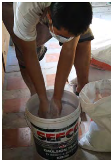
ภาพที่ 72 เทปูนผสมกับน้ำ
