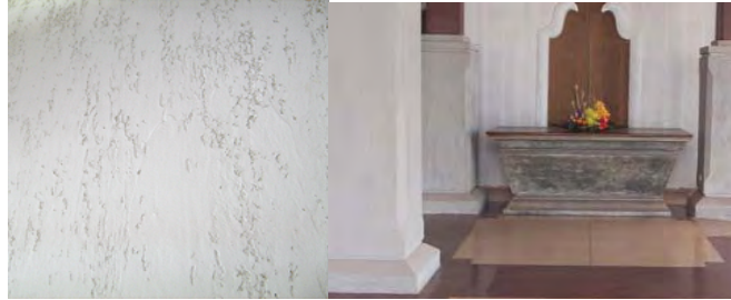
ภาพที่ 102 ภาพวัสดุฉาบผิวภายในอาคารที่เลือกใช้งานหินขัด TEROZZO ผสมเนื้อแคลไซต์ที่มีสีขาวประกายของแคลไซต์ที่จะสะท้อนแสงเป็นประกายขาวยามต้องแสงแดด
