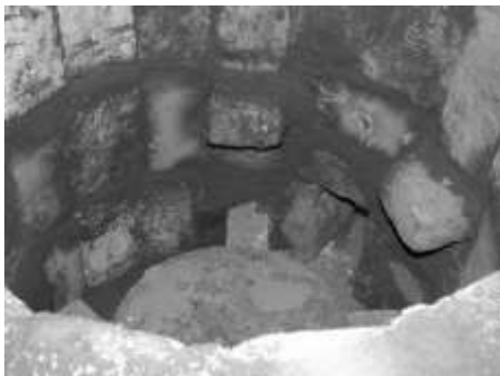
รูปที่ 3.11 การก่อผนังชั้นอิฐทนไฟ
