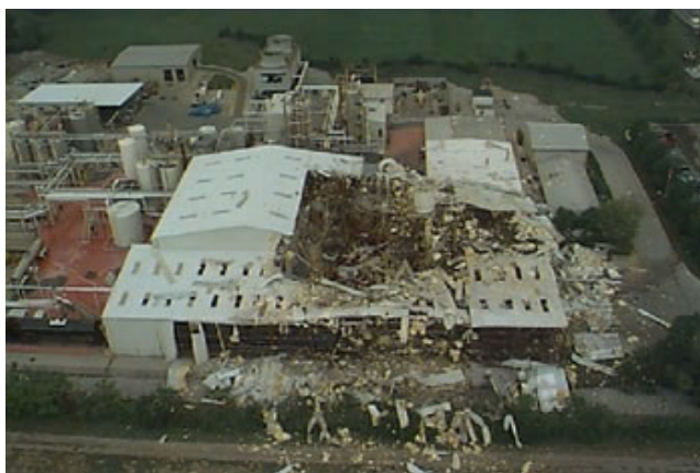
ภาพที่ 2 ความเสียหายจากเหตุการณ์เกิดปฏิกิริยาที่ไม่สามารถควบคุมได้ที่เมือง Columbus, Ohio ปี 1997
