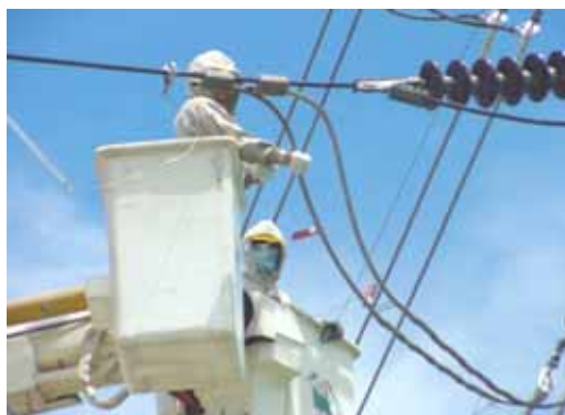
ภาพที่ 4 หน่วยสอทไลน์กระเช้า ระบบ 115 กิโลโวลต์ (Barehand Technique)
