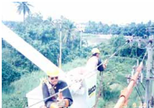
ภาพที่ 3 หน่วยสอทไลน์กระเช้า ระบบ 22-33 กิโลโวลต์ (Rubber Glove Technique)
