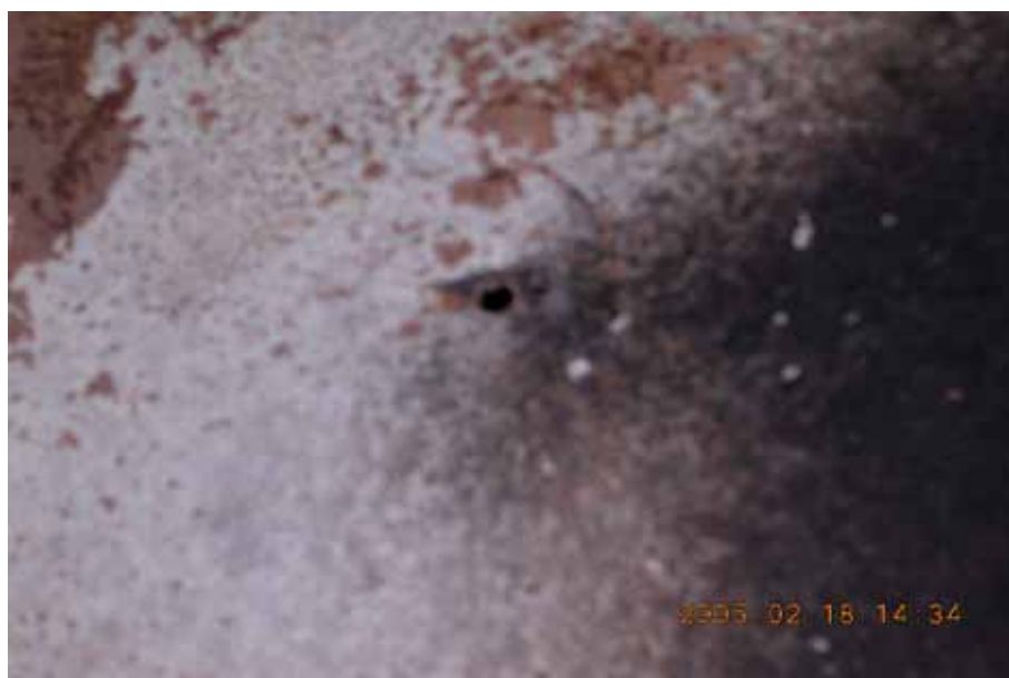
ภาพผนวกที่ ก6 แสดงขนาดรูที่เจาะตัวถังเก็บฝุ่นไม้เพื่อติดตั้งอุปกรณ์ตรวจจับความร้อน
