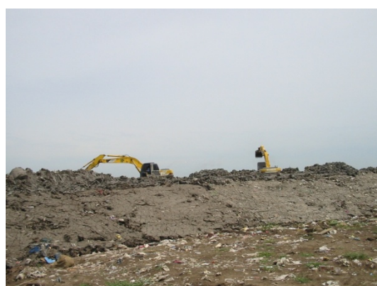
ฉ. กองมูลฝอย D4 ขณะใช้น้ำดินกลบทับ (กันยายน พ.ศ. 2550)
