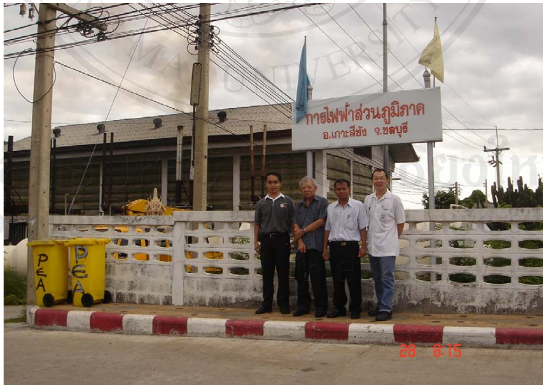
รูป 4.15 ที่ตั้งการไฟฟ้าส่วนภูมิภาค อำเภอเกาะสีชัง จังหวัดชลบุรี
