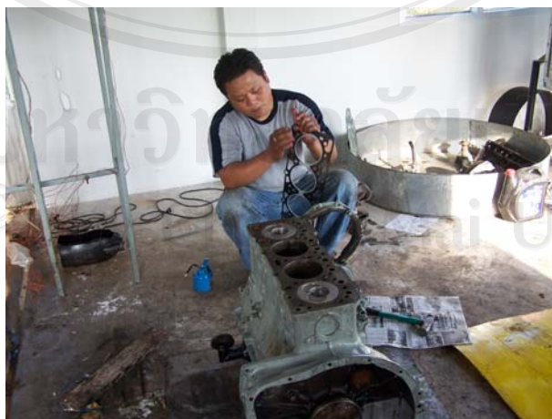
รูป 3.5 การถอดชิ้นส่วนเครื่องยนต์ดีเซลกำเนิดไฟฟ้าขนาด 25 กิโลวัตต์ (ณัฐวุฒิ และคณะ, 2551)
