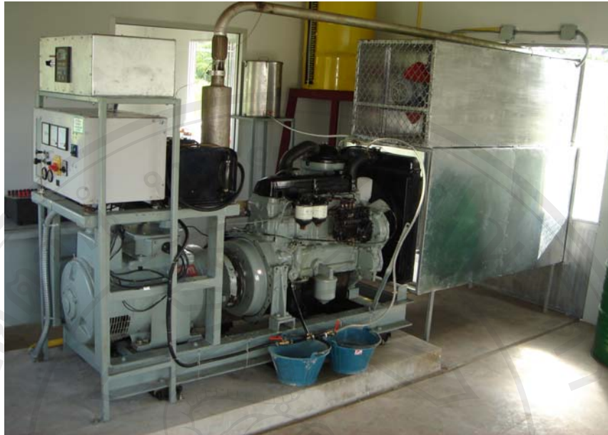
รูป 3.6 การติดตั้งเครื่องยนต์ดีเซลกำเนิดไฟฟ้าขนาด 25 กิโลวัตต์ กับแท่นทดสอบ (ณัฐวุฒิ และคณะ, 2551)
