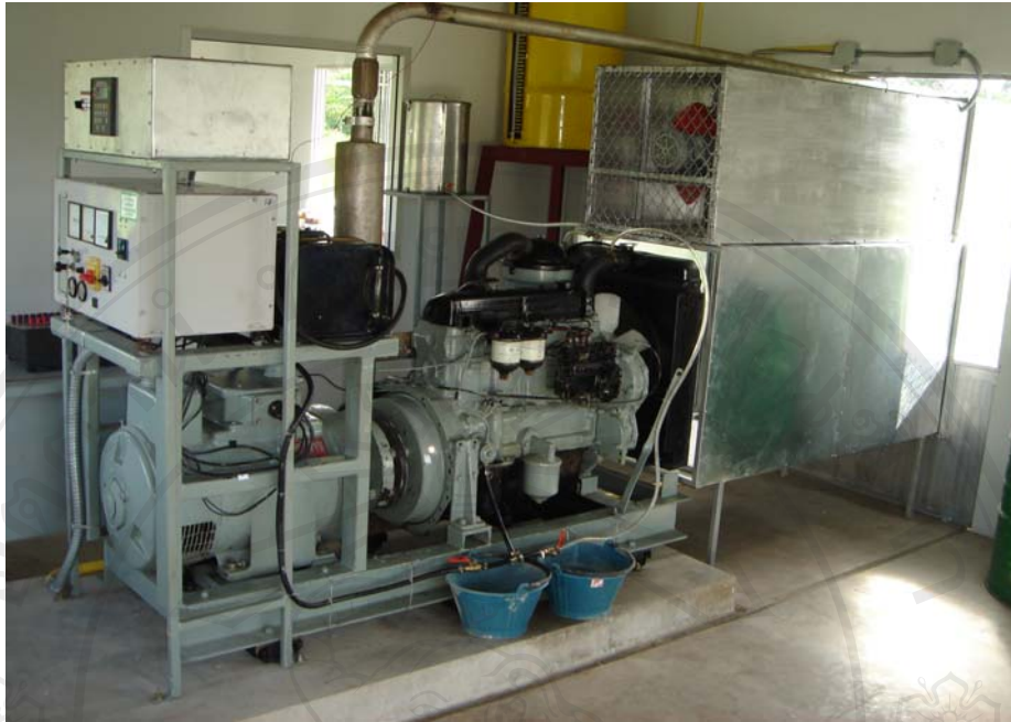
รูป 3.8 เครื่องยนต์ดีเซลกำเนิดไฟฟ้าห่อ FORD ขนาด 25 กิโลวัตต์ (ณัฐวุฒิ และคณะ, 2551)
