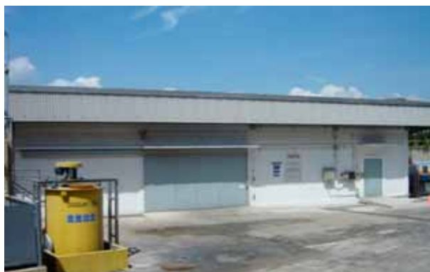
ภาพที่ 8 ภาพแสดงลักษณะของตัวอาคารห้องเก็บสารเคมีไวไฟซึ่งมองจากภายนอก
