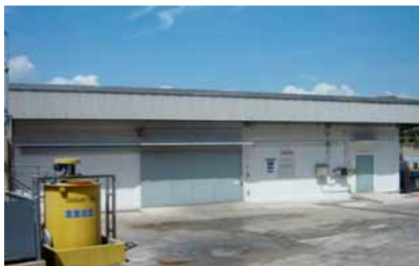
ภาพที่ 8 ภาพแสดงลักษณะของตัวอาคารห้องเก็บสารเคมีไวไฟซึ่งมองจากภายนอก
