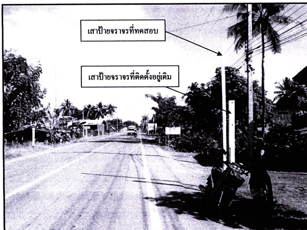
รูปที่ 3.9 เสาป้ายจราจรที่ทำการติดตั้งใหม่เพื่อการทดสอบงานวิจัย
