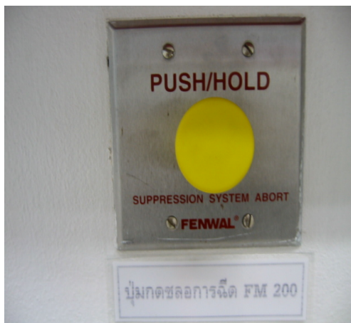
ภาพที่ 16 สวิตช์ระงับการทำงาน (Abort Switch)
