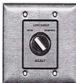
ภาพที่ 14 สวิตช์เลือกแหล่งจ่ายสารดับเพลิง
