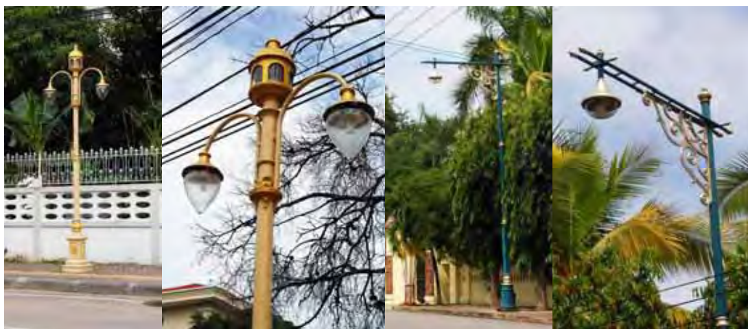
ภาพที่ 9 แสดงตัวอย่างโคมไฟถนนของจังหวัดเพชรบุรีที่ใช้อยู่ในปัจจุบัน
