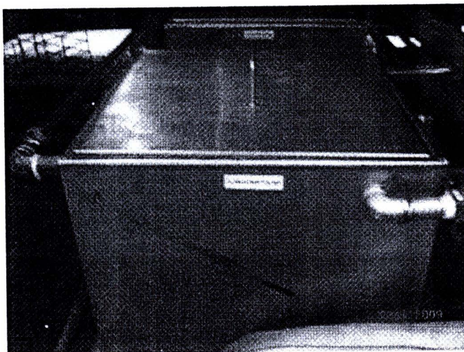
รูปที่ 30 ถังเก็บน้ำยาถึงที่หนึ่ง
