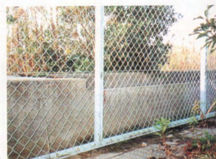
ทางระบายน้ำคัน Spillway
