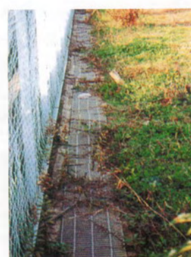
ท่อรวบรวมน้ำ Collecting Conduit
