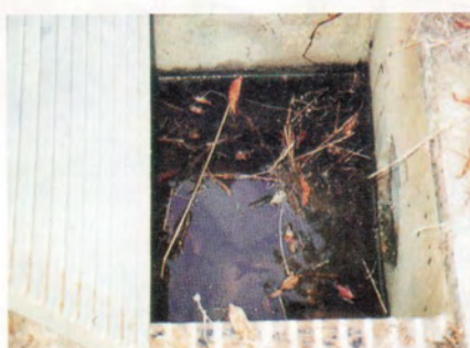
รางรวบรวมน้ำ Collecting Ditch
