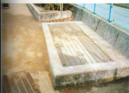
ทางระบายน้ำล้น Spillway
