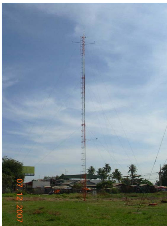
รูปที่ 3.6 แสดงการติดตั้งเสาวัดลมที่สถานีพนมเปญ
