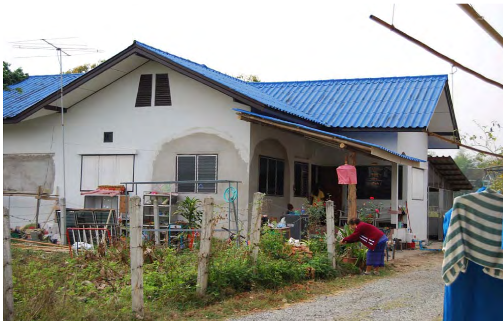
ภาพที่ 23 แสดงลักษณะอาคารผู้ที่อยู่อาศัยพื้นที่โครงการทางด้านหน้าของโครงการ
