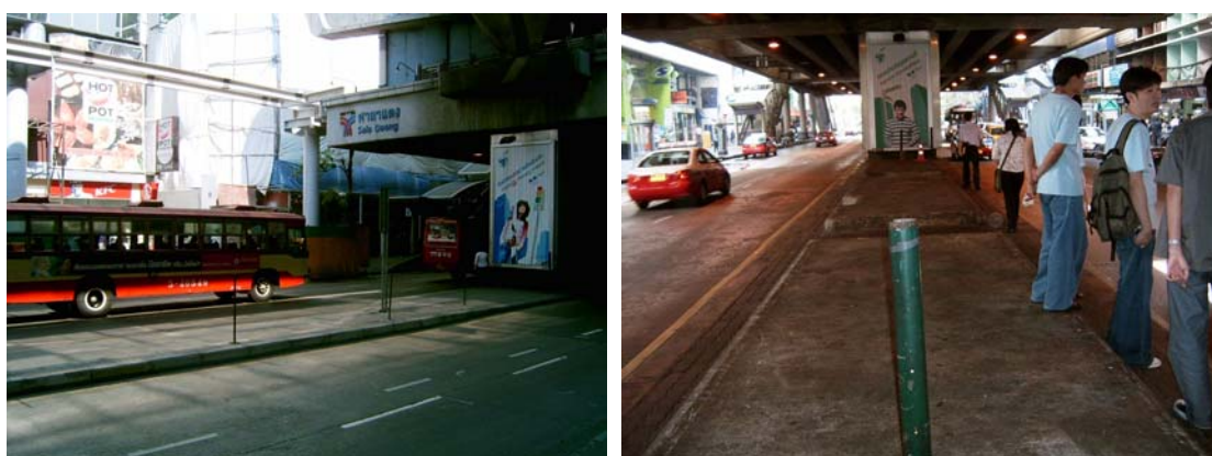
ภาพที่ 15 สถานีศาลาแดง ที่ลักษณะโครงสร้างของสถานีคล้ายอุโมงค์
