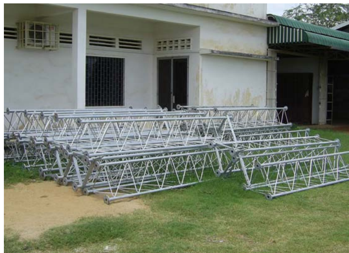
รูปที่ A1 แสดงชิ้นส่วนของเสาวัดลม ซึ่งจะนำไปติดตั้งในกัมพูชา
