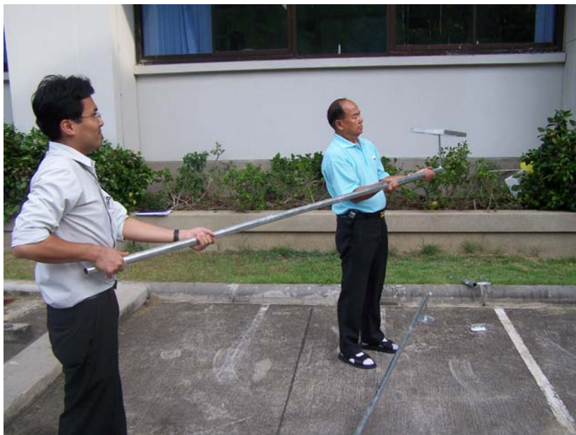
รูปที่ A3 แสดงแขนพร้อมแผ่นรองโซลาร์เซลล์ ซึ่งจะนำไปติดบนเสาวัดลม
