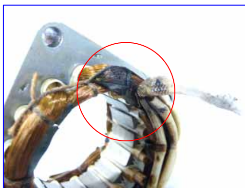
ภาพที่ 9 แสดงการอาร์ค-ลัดวงจรบริเวณขดลวดของเครื่องใช้พัดลมไฟฟ้ายี่ห้อ A จากการใช้งานสถานะผิดปกติเกิดการล๊อคแกนโรเตอร์ ประกอบกับได้รับแรงดันไฟฟ้าเป็น 242 V หลังเปิดใช้งานเป็นระยะเวลา รวม 6:30 ชั่วโมง
