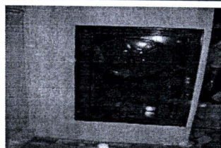
ตู้สายฉีดน้ำดับเพลิง (FHC)
