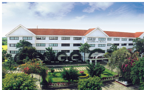
ช่างไฟฟ้ากำลัง
