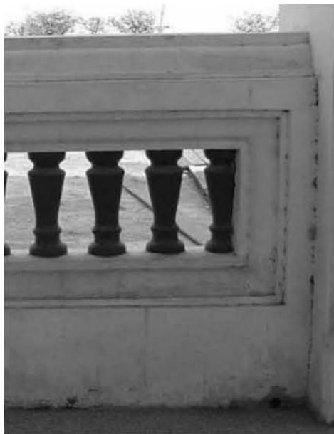
ภาพที่ ๕๘ พนักเจดีย์การเปรียญ ใช้ลูกกรงกระเบื้องเคลือบสีแบบจีน
