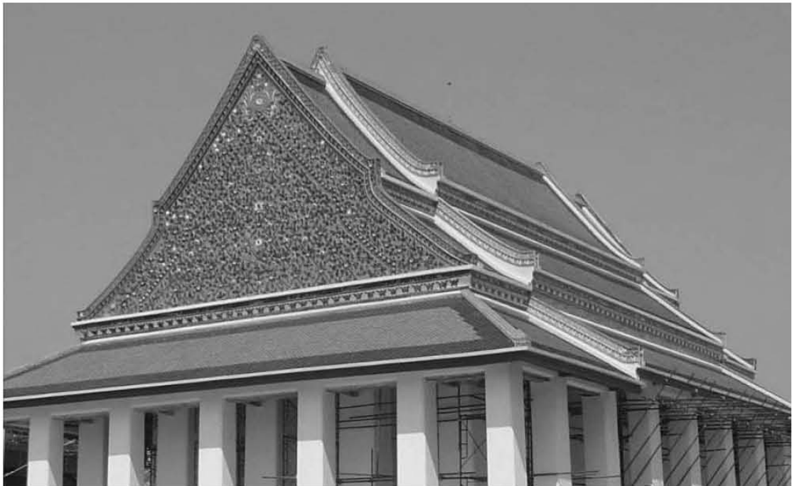
ภาพที่ ๑๑๒ หลังคาการเปรียญ กระเบื้องเคลือบสี
