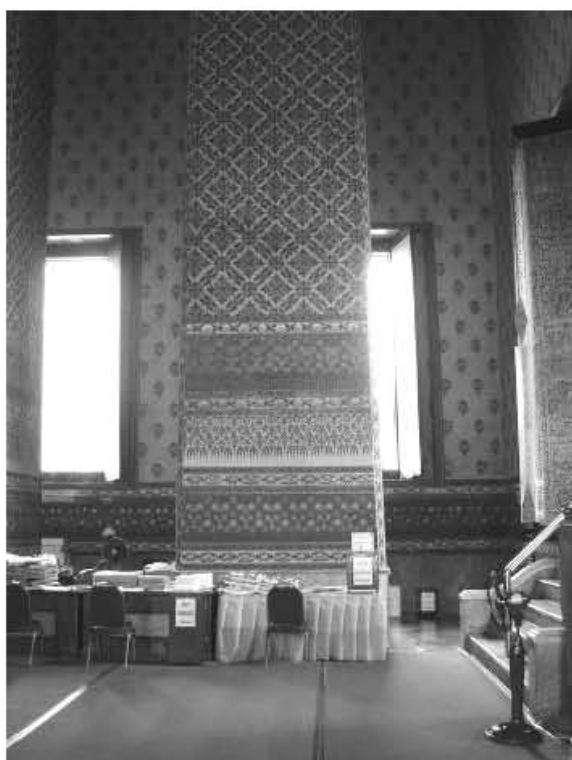
ภาพที่ ๔๗ เสาร่วมในพระวิหารหลวง ไม่มีบัวหัวเสา
