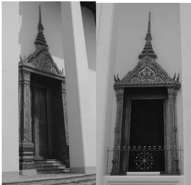
ภาพที่ ๑๖๖ ซุ้มประตูหน้าต่าง พระวิหารหลวงปั้นปูนเป็นซุ้มบันแถลงยอดปราสาท
