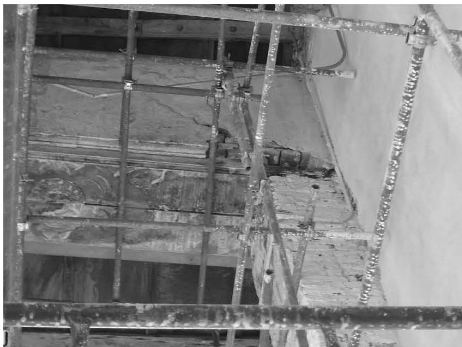
ภาพที่ ๒๒๓ การใช้แผ่นไม้เป็นทับหลังก่อนก่ออิฐเป็นคอสอง
