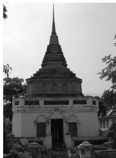
ภาพที่ ๑๒๘ เจดีย์หินแกรนิตเหลี่ยมย่อมุมไม้สิบสองบนฐานสูง
