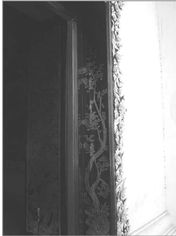
ภาพที่ ๒๒๒ ช่องประตูใช้แผ่นไม้เป็นทับหลังไม้ก่อนก่ออิฐเป็นผนัง
