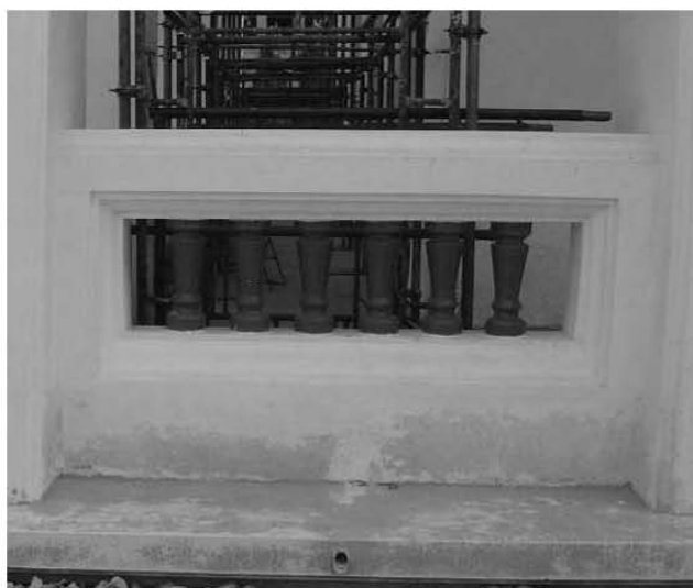
ภาพที่ ๖๕ พนัคนเกลี้ยงพระอุโบสถแบบลูกมะหวดดินเผาเคลือบสีแบบจีน
