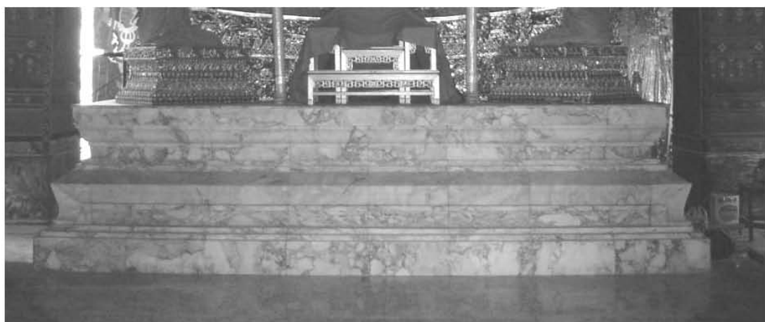
ภาพที่ ๑๑๘ ฐานชุกชีชั้นล่างเป็นฐานสิงห์ ทำจากหินอ่อน
