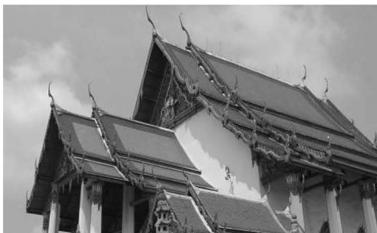
ภาพที่ ๒๐๑ หลังคาพระวิหารวัดสุทัศนเทพวราราม หลังคา ๔ ชั้น ๒ ชั้นและมุขลดได้ซ้อน
