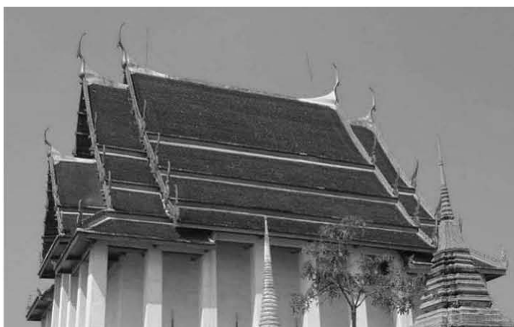
ภาพที่ ๒๐๐ หลังคาพระวิหารหลวง ๔ ชั้น ๒ ชั้นและมุขลดได้ซ้อน
