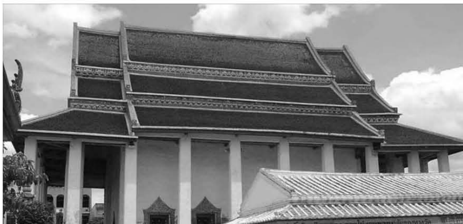
ภาพที่ ๒๐๓ หลังคาพระอุโบสถ หลังคา ๓ ตับ ๒ ซ้อน
