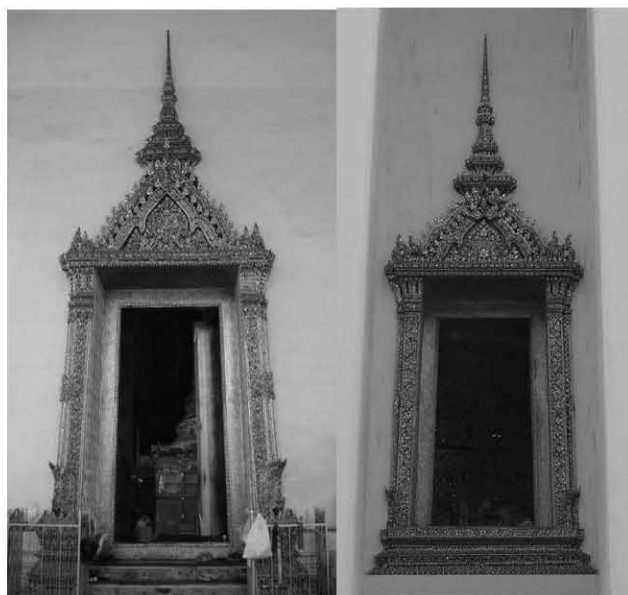
ภาพที่ ๑๖๗ ซุ้มประตู หน้าต่างพระอุโบสถวัดสุทัศน์ทรงบันแถลงยอดปราสาท
