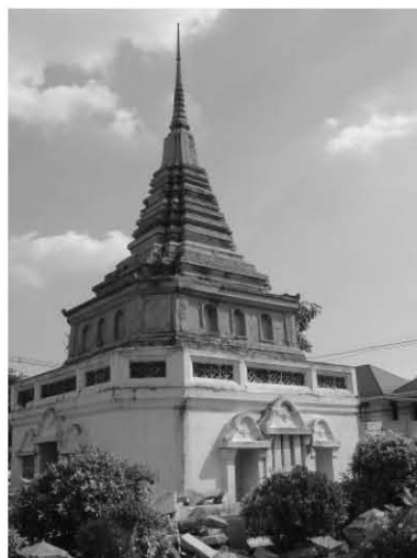
ภาพที่ ๑๒๘ เจดีย์หินแกรนิตเหลี่ยมย่อมุมไม้สิบสองบนฐานสูง
