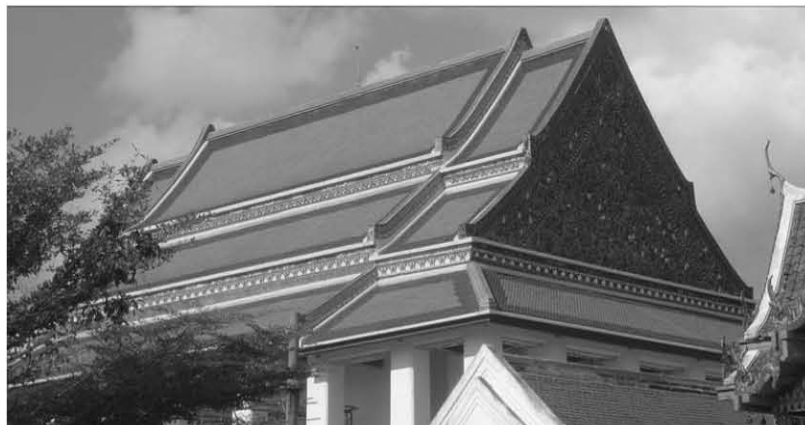
ภาพที่ ๒๐๔ หลังคาการเปรียญ หลังคา ๓ ชั้น ๒ ชั้น
