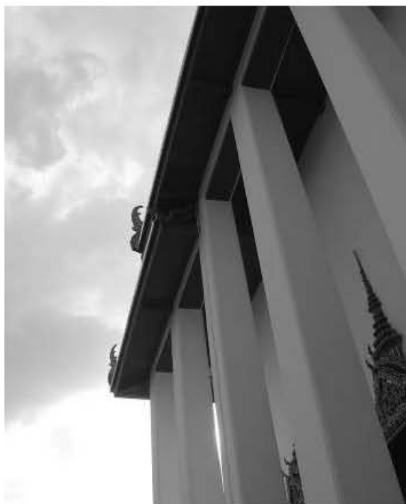
ภาพที่ ๔๖ เสาพะไลพระวิหารหลวงก่ออิฐถือปูนทาสีขาว ไม่มีบัวหัวเสา
