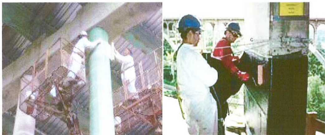
รูปที่ ๒.๒๓ คาร์บอนไฟเบอร์เสริมแรงพอลิเมอร์ในการประยุกต์ใช้ในงานคอนกรีตเสริมเหล็ก
