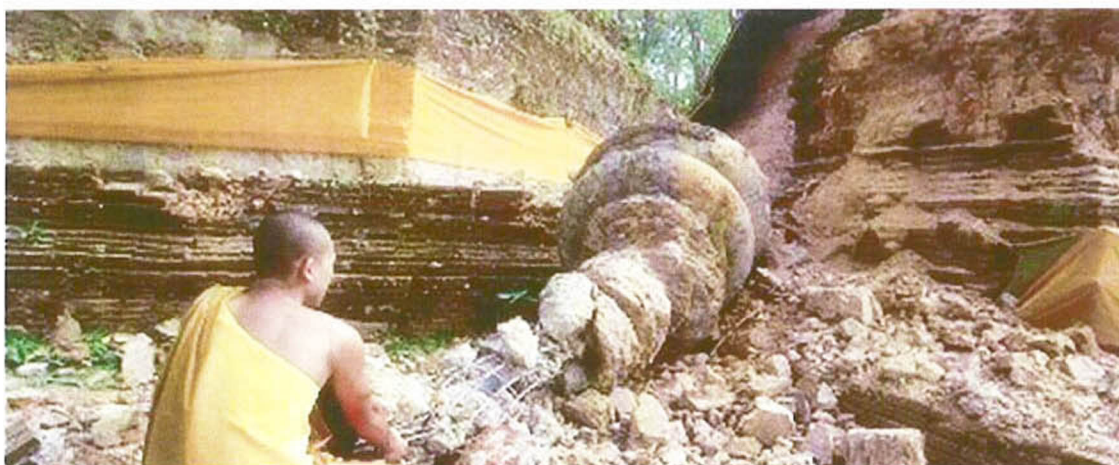
รูปที่ ๑.๒ การพังทลายของโบราณสถานประเภทเจดีย์ ในจังหวัดเชียงราย จากเหตุการณ์แผ่นดินไหวขนาด ๖.๘ ริกเตอร์ในพม่า ณ วันที่ ๒๔ มีนาคม ๒๕๕๔
