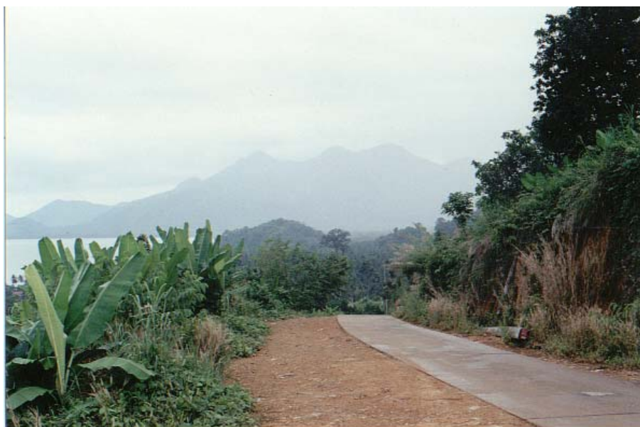
รูปที่ 2-4 ถนนคอนกรีตเสริมเหล็ก
