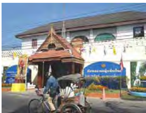
ภาพที่ 58 รูปด้านหน้าอาคารทักษสถานหญิงเชียงใหม่
