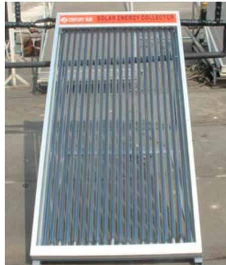
รูปที่ 2 แผงรับแสงอาทิตย์แบบท่อฮีตไปป์
