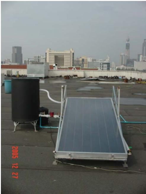
รูปที่ 3 ระบบทำน้ำร้อนแบบแผ่นเรียบ
