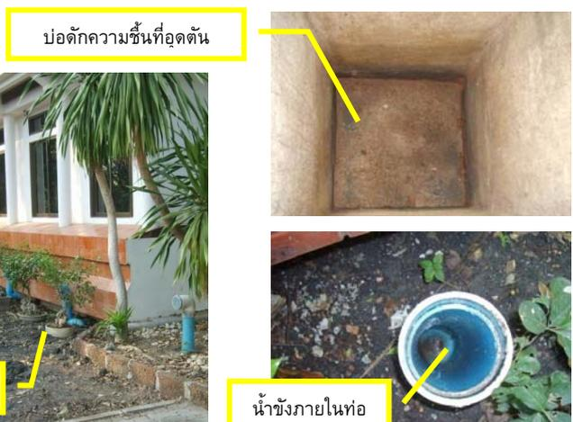
รูปที่ 11 บดักความชื้นที่อุดตันและน้ำที่ขังภายในระบบท่อ
