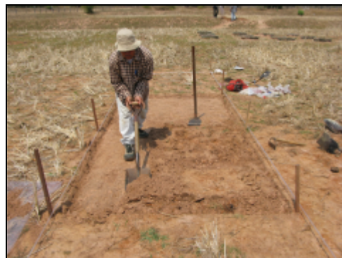
การขุดหน้าดินที่เป็นดินเค็มออกไป
