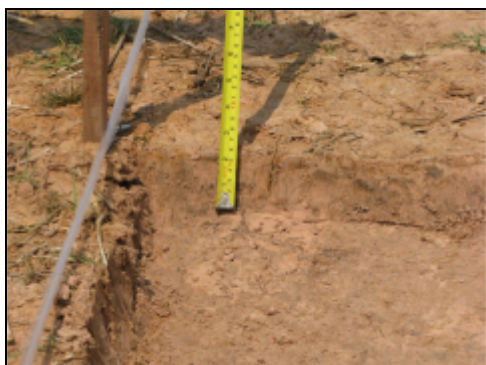
ขุดดินลึกประมาณ 5 เซนติเมตร
