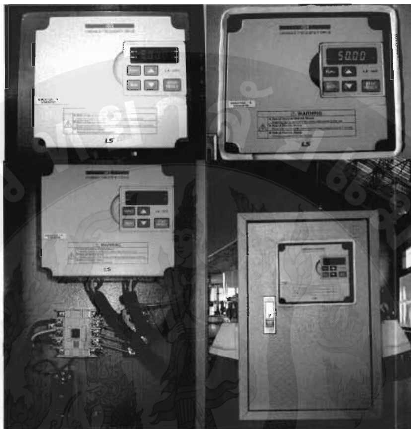
ภาพที่ 3.11 อุปกรณ์ควบคุมความเร็วรอบของมอเตอร์
