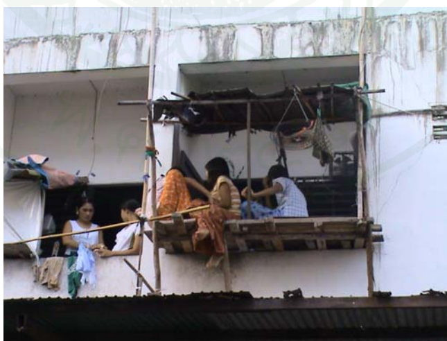
ภาพที่ 8 การต่อเติมห้องเพื่อเป็นที่นั่งเล่นพักผ่อนหย่อนใจ
